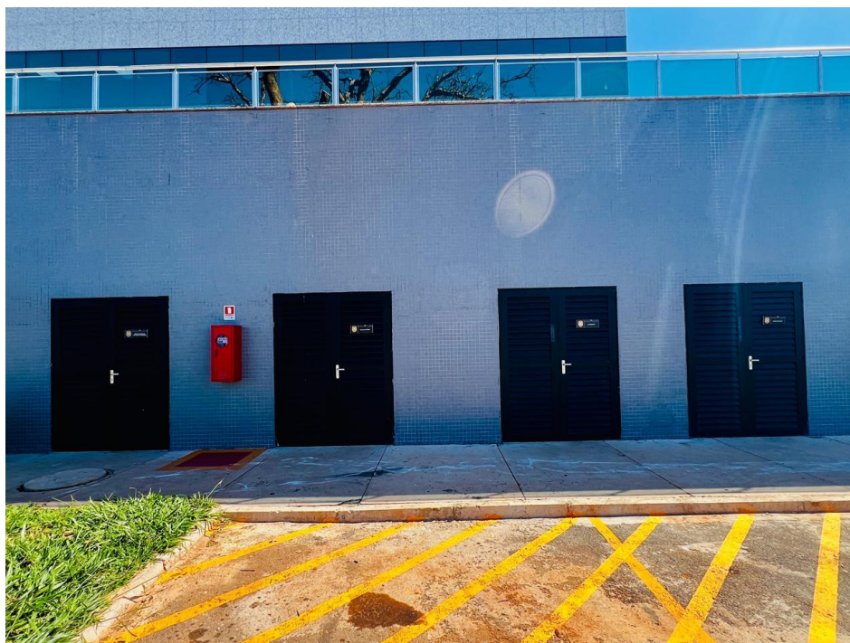
Baias para o acondicionamento dos resíduos
